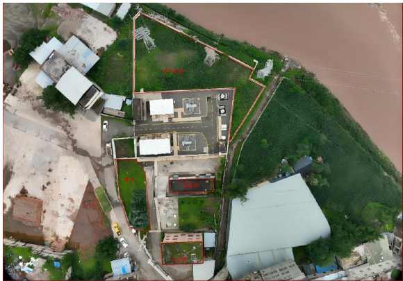
牛牛坝变电站现状
