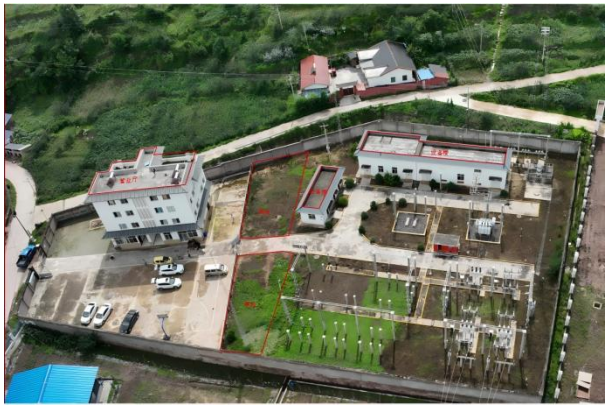
峨曲古变电站现状
